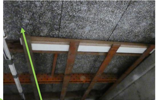
Deckenbereiche sind mit massiven Platten verkleidet. Dacheindeckung aus Faserzementplatten.
