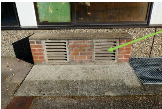
Lüftungsschacht – Lüftungsspalten sind mit Insektenschutzgittern verschlossen – keine Nutzung / kein Zugang für Fledermäuse möglich
