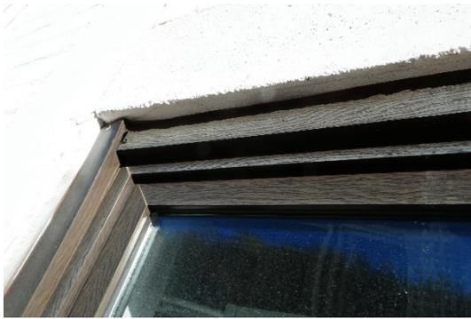
Fenstereinbauten ohne Spalten oder Öffnungen für eine potenzielle Nutzung durch Fledermäuse
