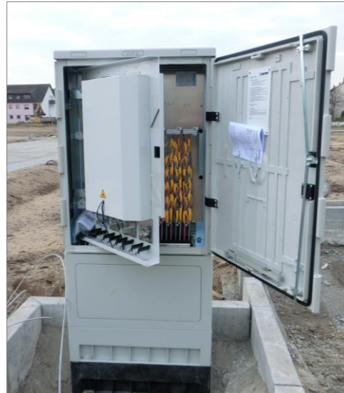
Netzverteiler
