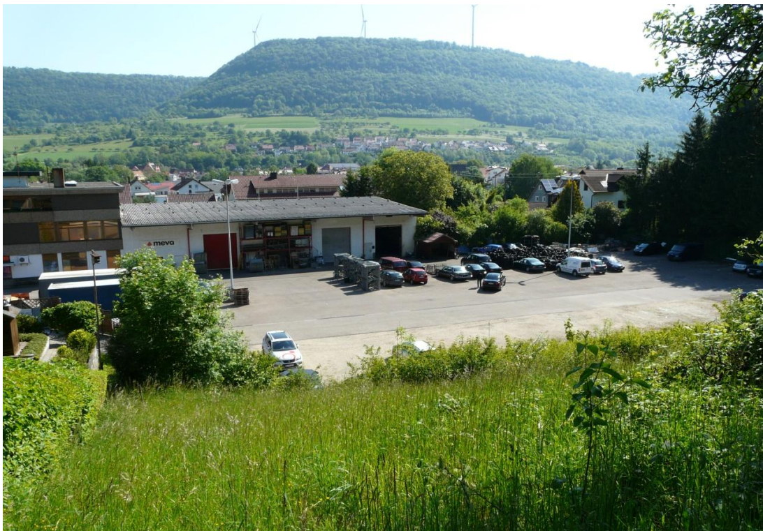
Abbildung 12: Ansicht Plangebiet von Süden.
